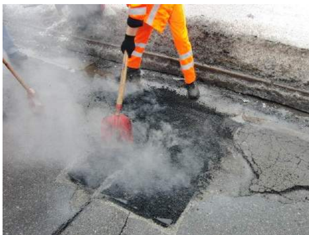
Verteilung des PFA® Mischgutes im Schlagloch
