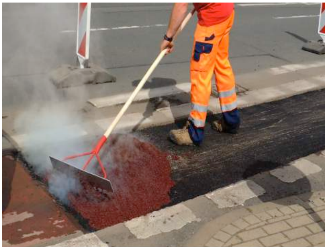
Einbau der dünnen PFA®Colorasphalt Schicht
