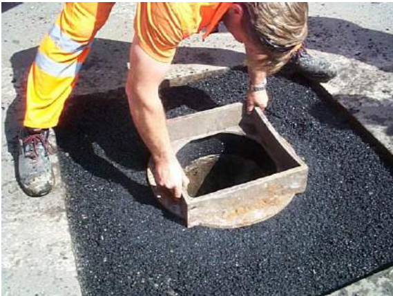
Auffüllen mit PFA® Asphalt
