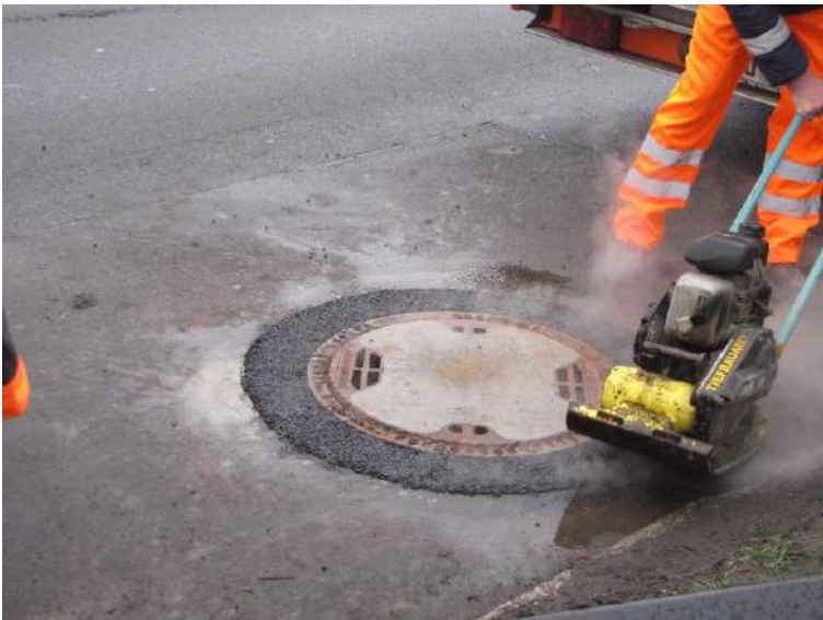
Manueller PFA® Asphalteinbau
