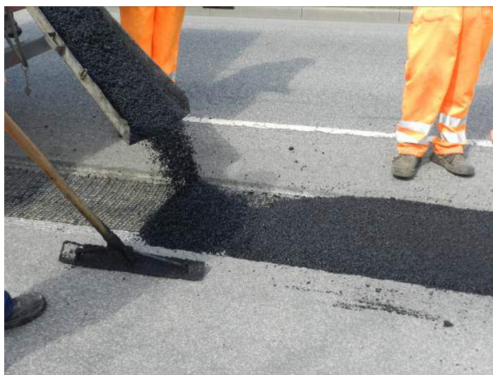
Einbau PFA® Asphalt
