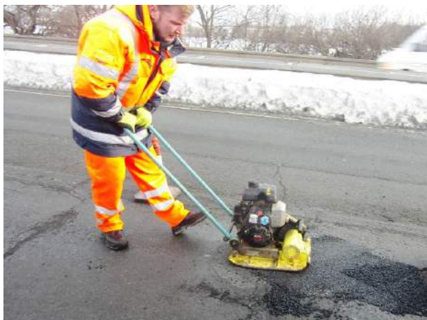
„sanfte“ Verdichtung mit Rüttelplatte; danach sofortige Verkehrsfreigabe
