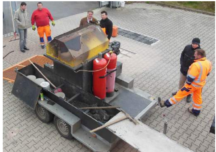
Aufbereitung des PFA® Asphaltmischgutes in Situ (mittels portablen Kleinmischer)
