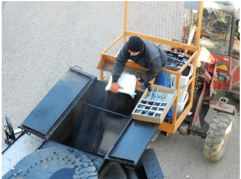
Herstellung PFA® Asphalt in Situ in einem Gußasphaltkocher zur Lochfüllung
