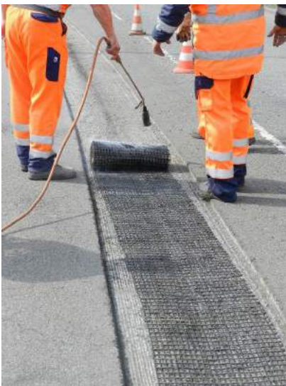
Einbau des Glasgitters (Anflammen)
