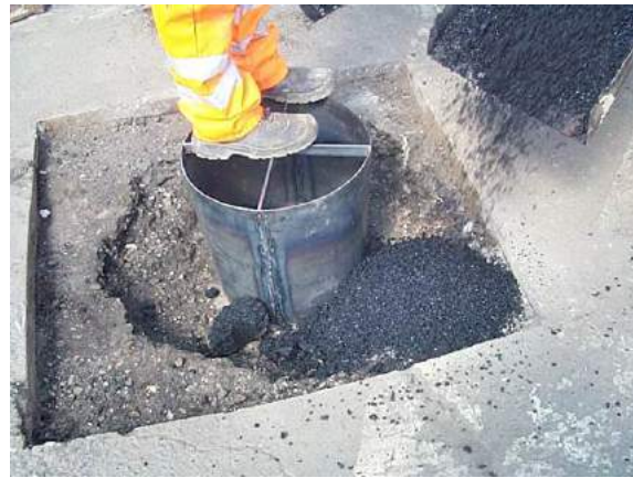
Einfügen der Form und Ausfüllen mit PFA®
