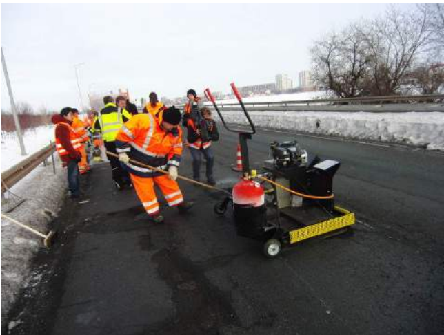
Vorheizen der Einbaustelle mit Flächenheizgerät
