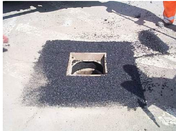
sanftes verdichten und einsetzen des Schachts
