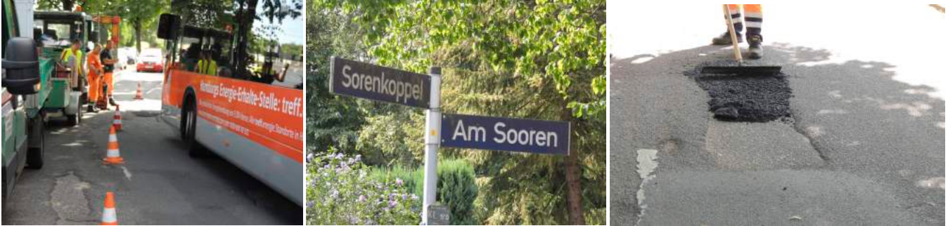
Einbau von PFA® Asphalt in Hamburg
