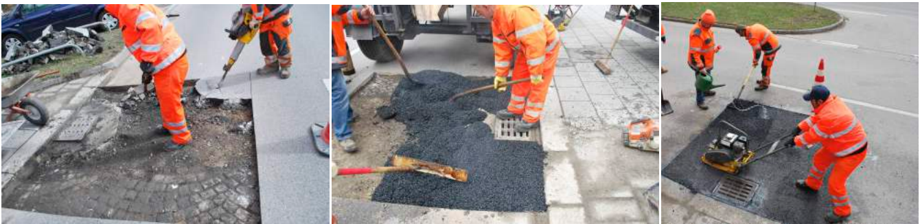
Einbau von PFA® Asphalt in München
