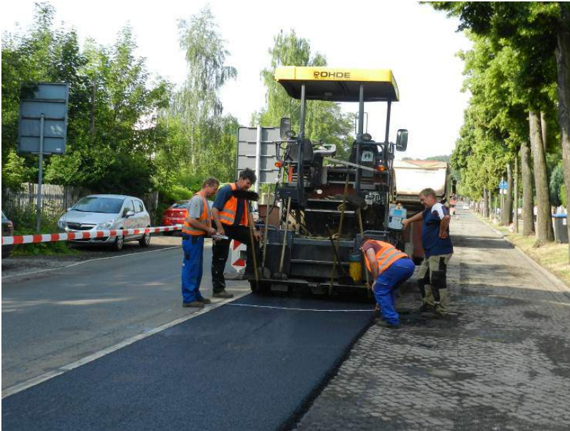
Einbau von PFA® Asphalt mit Straßenfestiger auf Pflaster in Erfurt
