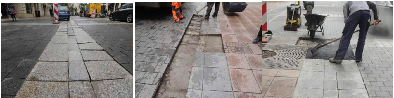
Einbau von PFA® Asphalt in Frankfurt/Main
