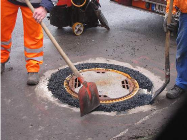
Manueller PFA® Asphalteinbau
