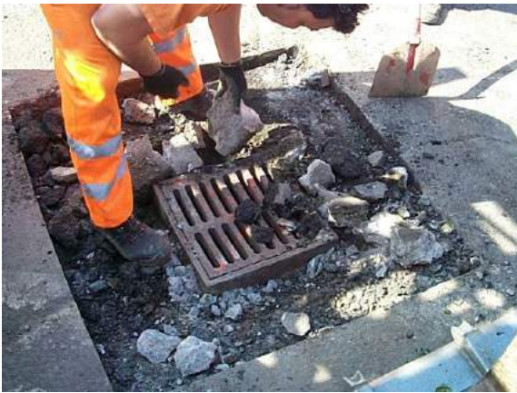
Sanierung alter Einläufe (Erfurter Lösung)
